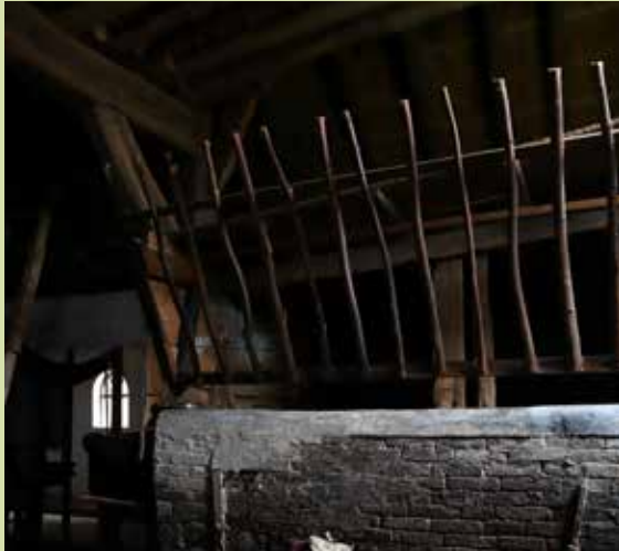
Paardenstal in het achterhuis met de kenmerkende ruif voor hooi en stenen bak voor water of ander voer.
